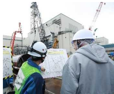
クライン委員長による安全対策工事の視察
