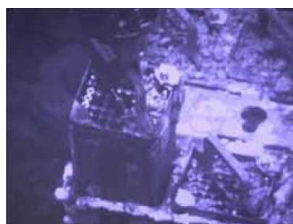
燃料取り出し作業
