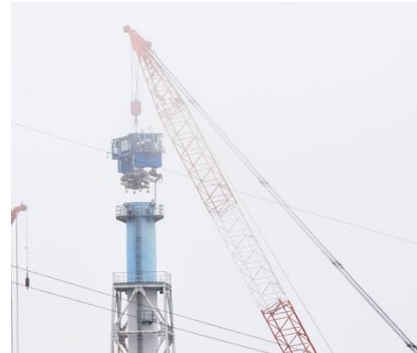
排気筒最頂部への設置確認作業
