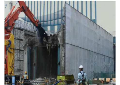
大物搬入口の解体
