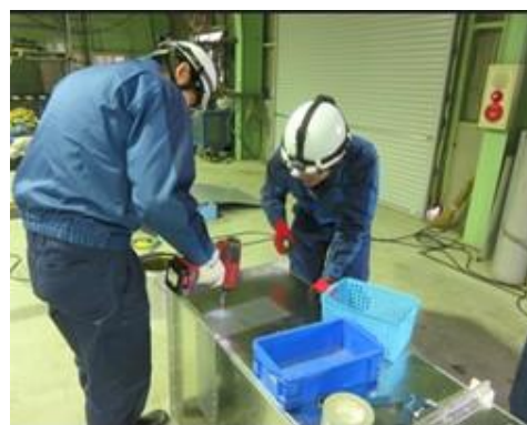
空調ダクト補修訓練
