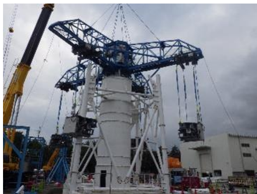
支柱材解体状況
