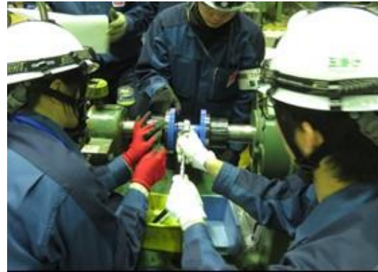
電動機分解・組立訓練
