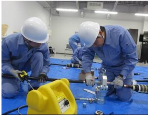
高圧ケーブル端末処理・接続訓練
