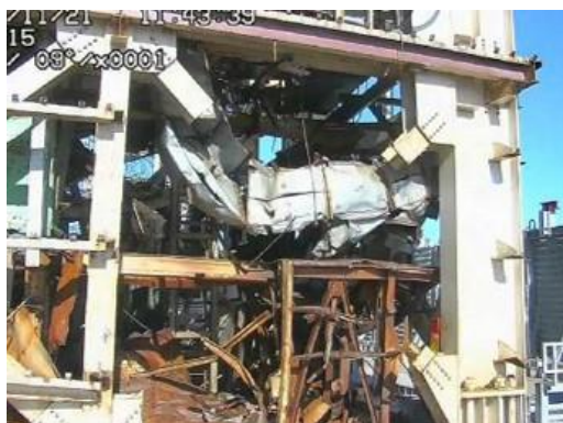
左；南面 X ブレース撤去後
