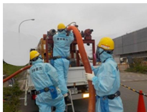
使用済燃料プール冷却設備損傷時対応訓練
