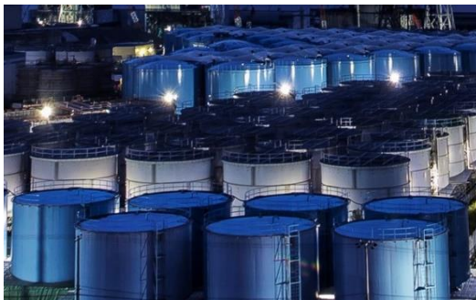
処理水貯蔵用タンク
