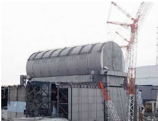
燃料取り出し用ドーム屋根設置完了
