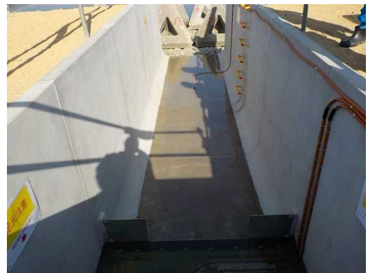
付替えした A 排水路
