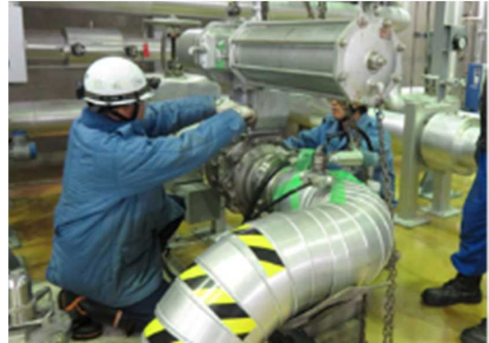
弁・駆動部点検（駆動部吊り上げ）
