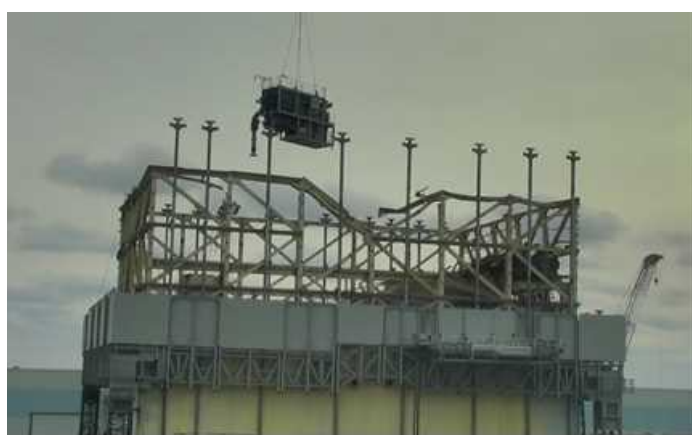
1号機ガレキ吸引装置の設置
