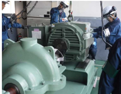
総合訓練（左：電動機取替訓練、右：ケーブル敷設訓練）
