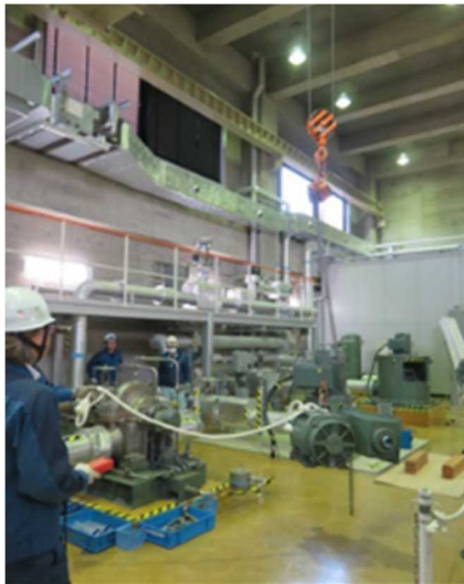
ポンプ分解点検（モータ吊り上げ）
