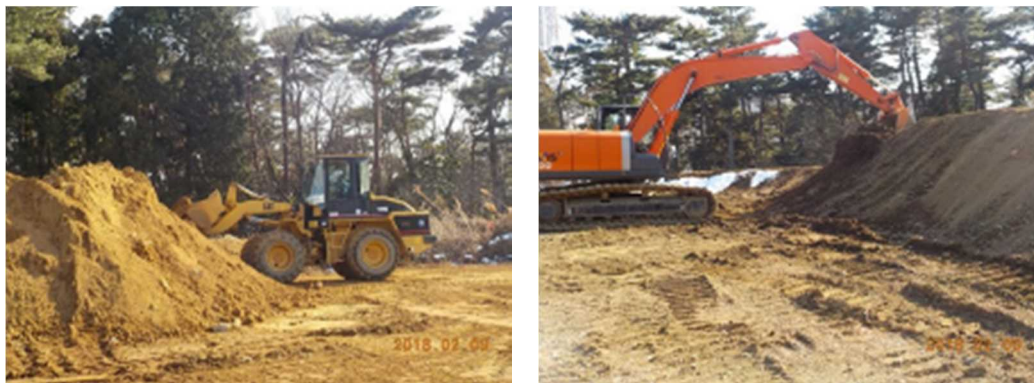
重機操作反復訓練
