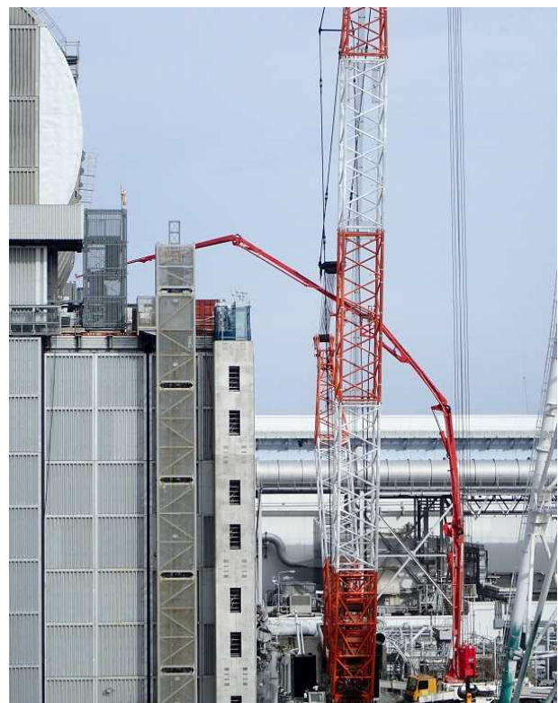
コンクリートポンプ車による注水訓練
