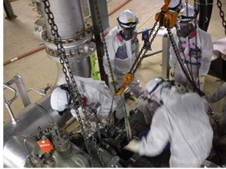
全面マスクを装着した状態でのポンプ軸受け分解訓練
