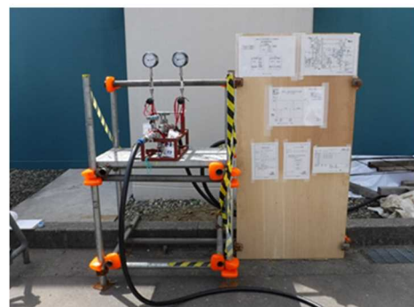
配管の耐圧試験（6号機）
