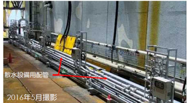
散水設備配管設置状況
