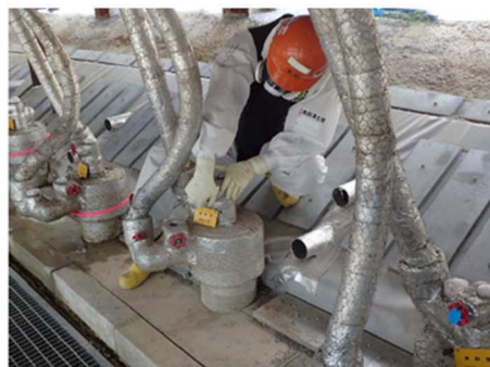
対象凍結管のバルブを開ける作業（フェーズ2）
