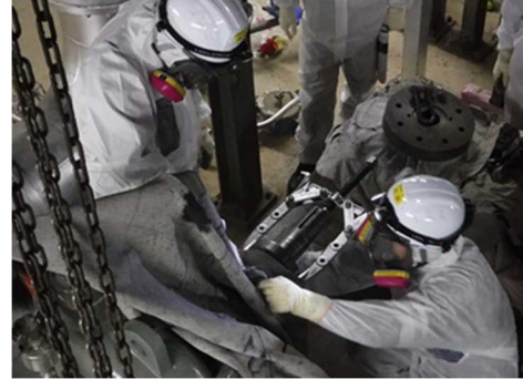
全面マスクを装着した状態でのポンプ軸受け分解訓練
