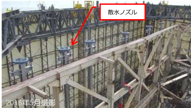
散水設備ノズルユニット設置状況
