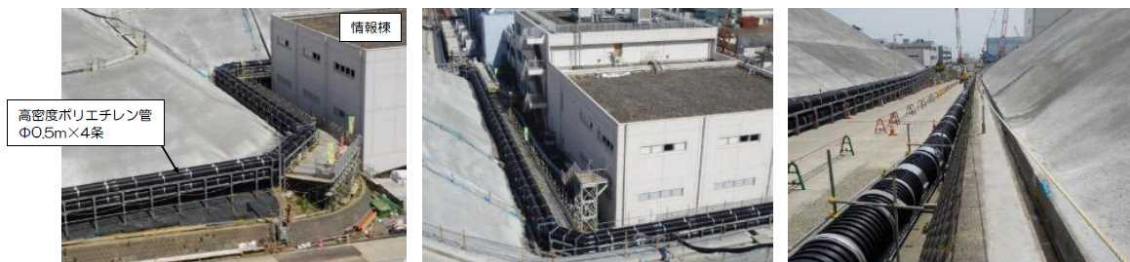
北側ルート配管状況（図：写真②）
