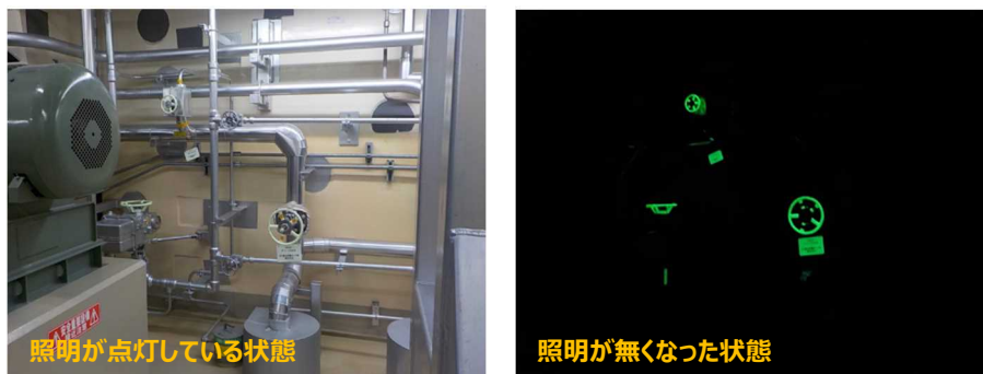
重要設備・避難誘導経路・避難標識等への高輝度蓄光材の採用（柏崎刈羽）
