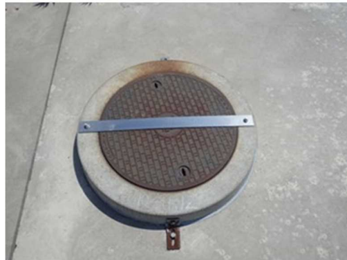
マンホール蓋の固定
